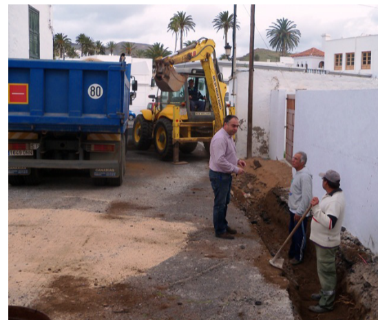
El edil Pedro Niz visita las obras en la Calle El Puente.
