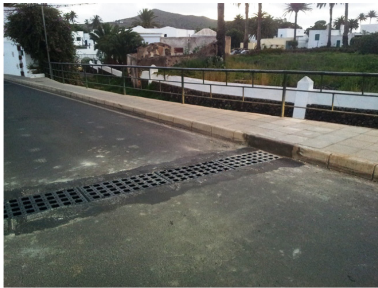
Obras en la Calle Ángel Guerra.
