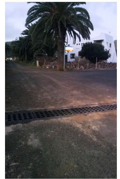
Obras en la calle Elvira Sánchez.
