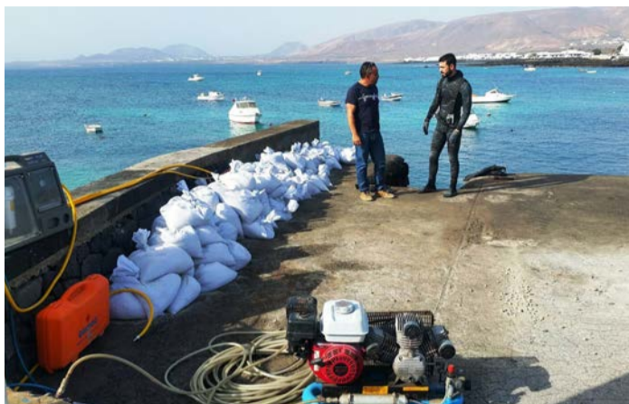
Obras de rehabilitación en Punta Mujeres.
