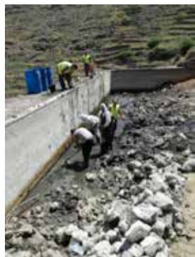
Obras en el embalse de Chafariz.
