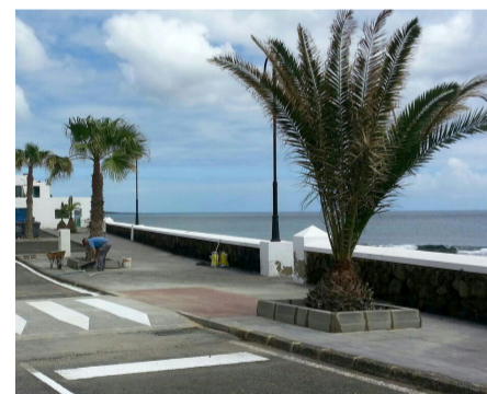
Obras de mejora en la calle Los Morros de Arrieta.
